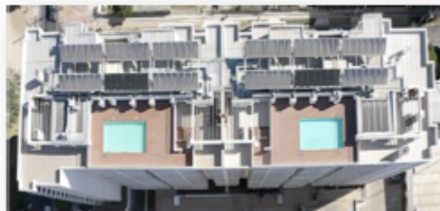
PANELES SOLARES (Sol)
